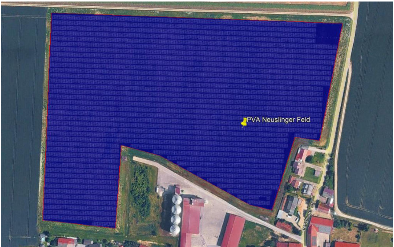
Bild 2.1.3: Detailansicht der PV Fläche (Quelle: Google Earth/SolPEG)
